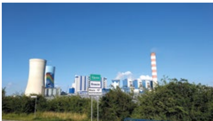
Fot. 1. Widok na Elektrownię Opole, usytuowaną pierwotnie w gminie Dobrzeń Wielki, obecnie włączoną w obszar miasta Opole
